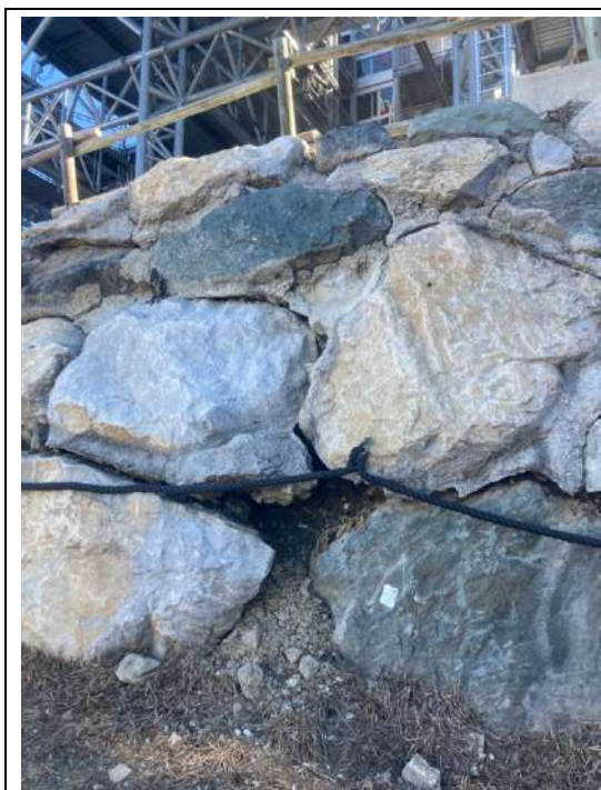
Figure 14 : Dislocation des blocs
