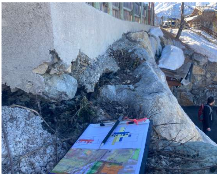
Figure 15 : Affaissement sous la longrine béton
